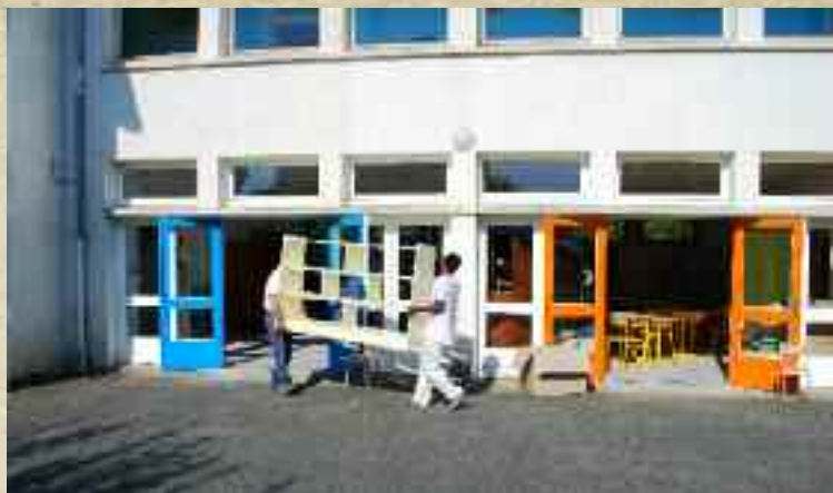
2 mois ! Délais tenus par les services techniques pour accomplir les travaux d'aménagement à l'école élémentaire « La clé des champs ». Plomberie et peinture, pour la création de nouvelles salles : une BCD, une salle d'activités et une salle des maîtres, aménagement d'une salle de classe, construction d'un préau (bravo à l'entreprise Robichon) et déménagement du matériel de l'école Jean Macé. De quoi permettre une rentrée sans heurts...
