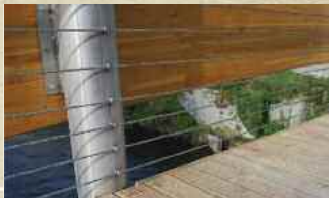
Détail de la passerelle
