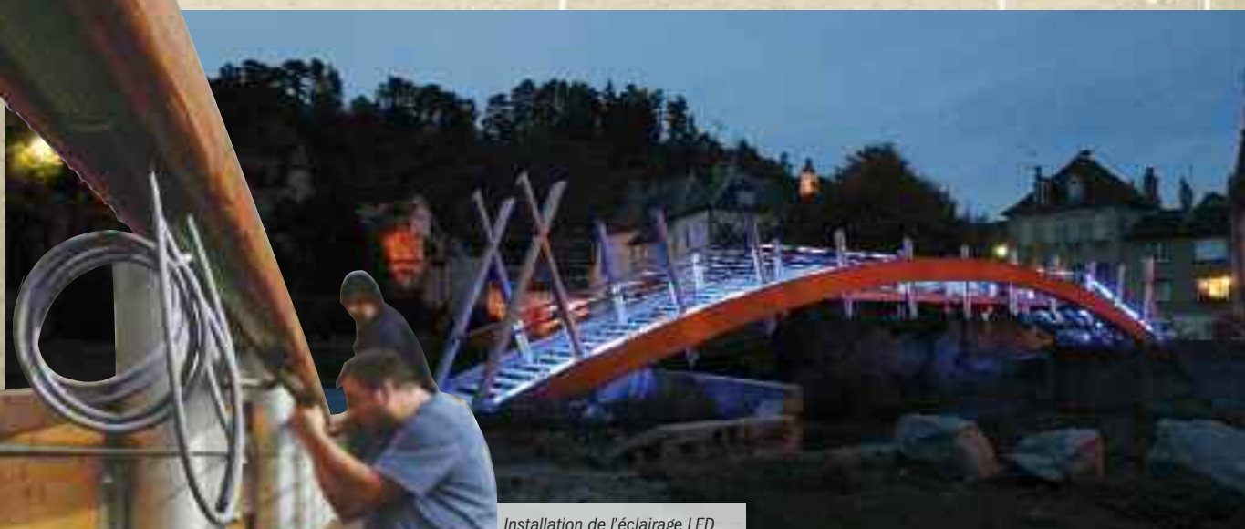
Installation de l'éclairage LED sur la passerelle par la société Led to Lite
