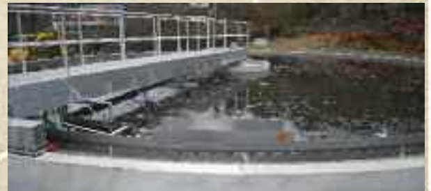
Le clarificateur entièrement réhabilité avec son nouveau pont racleur
