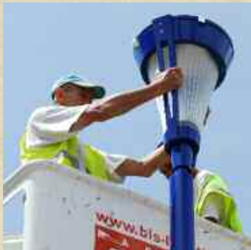
Installation lampadaires : depuis le mois d'avril, de nouveaux lampadaires éclairent les nuits du Pont Neuf.
